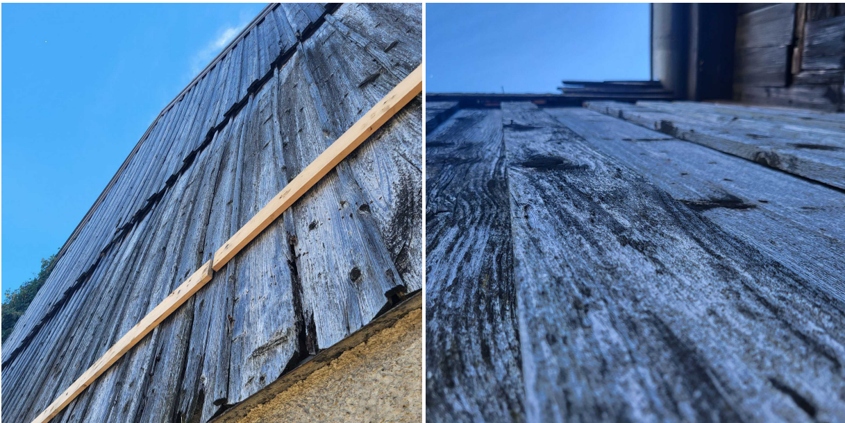
Abb. 2: An und unter der Holzverschalung vom Stadel konnte kein geeignetes Potenzial für Vögel oder Fledermäuse festgestellt werden.
