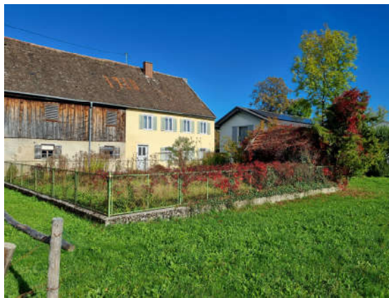
Blick von Südwesten auf das Anwesen
